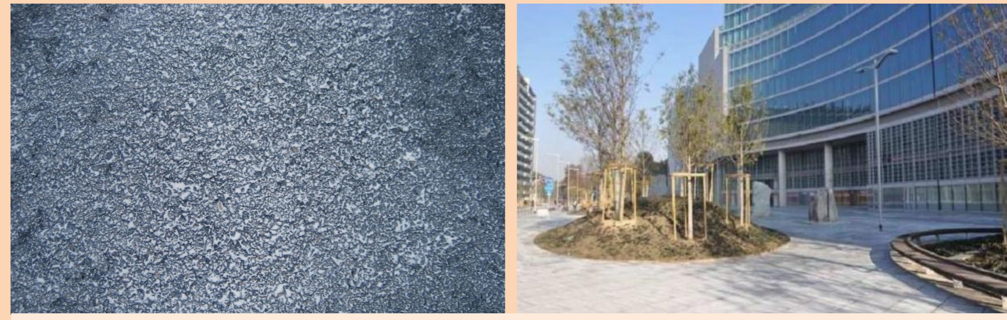
Acabado de extendido de spray fotocatalítico en mezcla bituminosa de calzada y en acera
