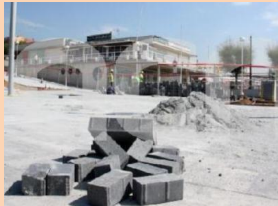
Fase de construcción de un acera de losetas aditivadas con \text{TiO}_2
